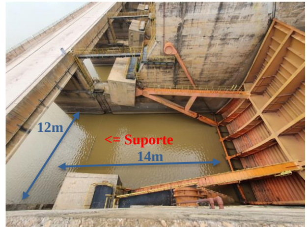
Figura 3: Posicionamento do sonar na parte interna da ponte sobre o vertedouro. (Fonte: Autores)
