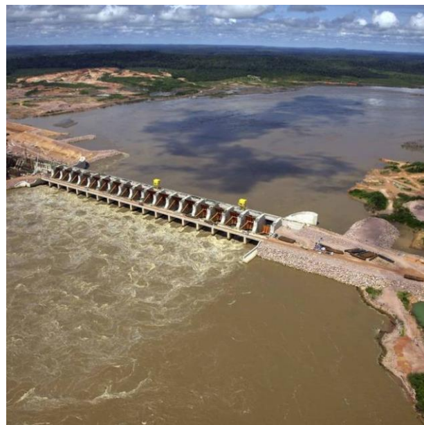
Figura 1: Área de estudo: Usina Hidrelétrica Jirau (Fonte: Google Maps, 2021)
