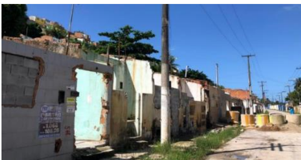
Figura 9: Barreira existente na frente da Braskem, no bairro Mutange, com bloqueio para passagem de veículos.
