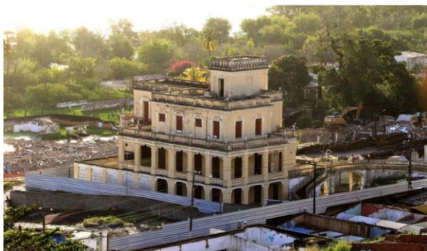
Figuras 8: Casarão histórico onde funcionava a casa José Lopes. Fonte: CBN.
