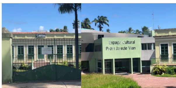
Figuras 8: Prédio da sede do Sintel (Sindicato dos trabalhadores de Alagoas), abandonado. Fonte: Autores (2020).
