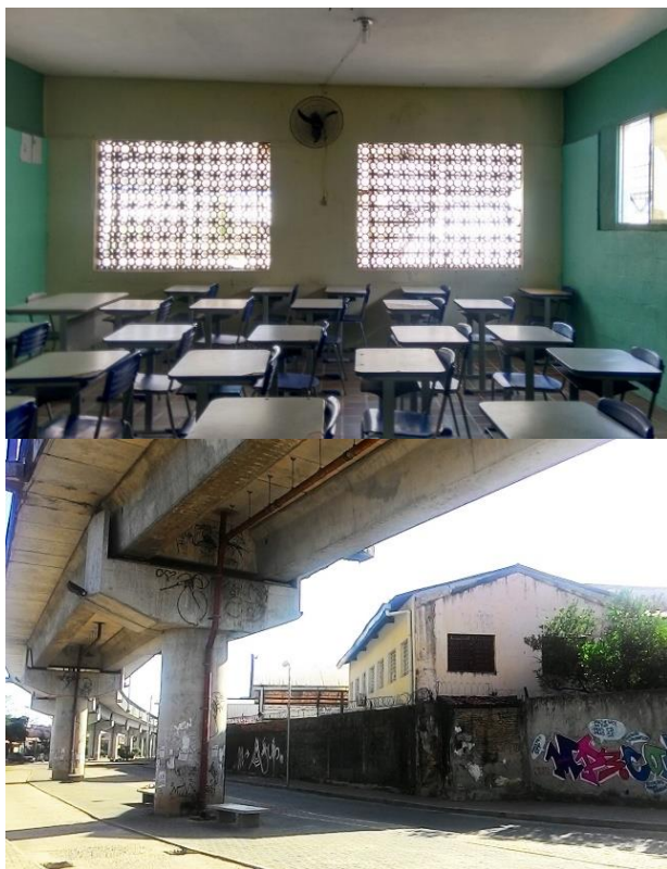
Figura 5: ESCOLA A: Visto do Ponto P4 (em cima) e Visita externa da fachada mais próxima à plataforma do metro (embaixo).
