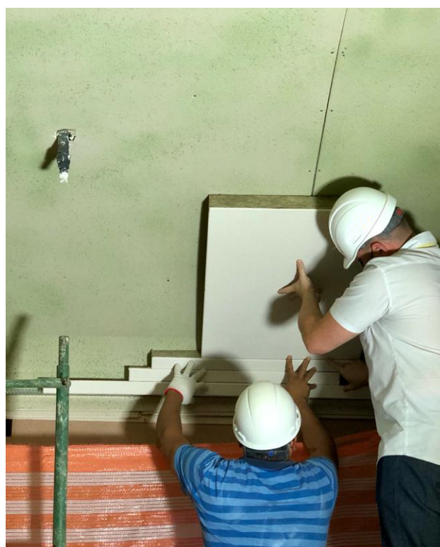
Figura 2: Início da instalação do revestimento acústico no forro côncavo, sem as suas camadas finais.
