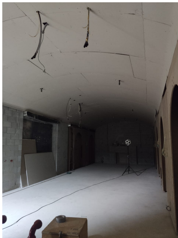
Figura 4: Jazz Bar sem solução no forro côncavo durante a primeira medição do ( T_{20} ).
